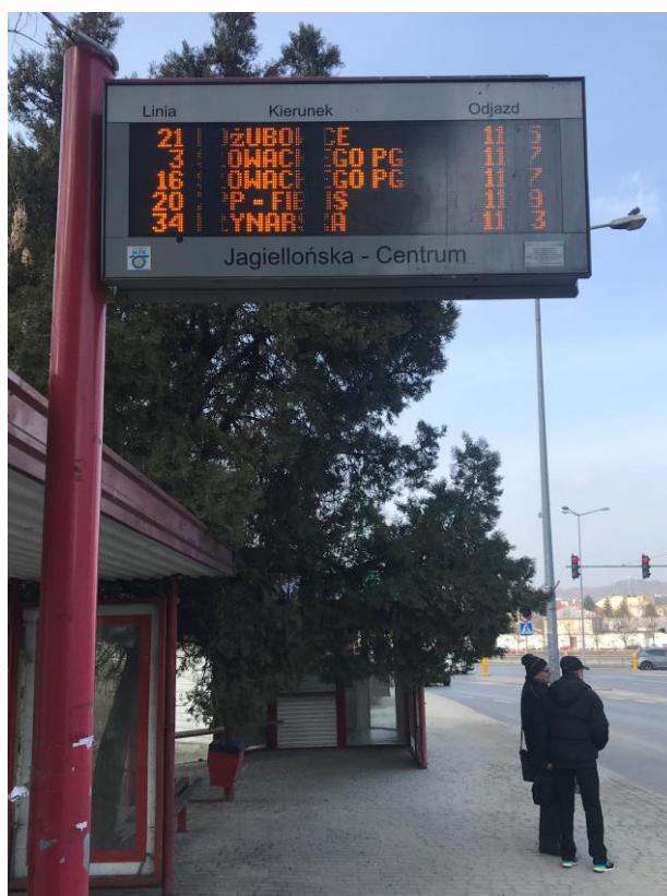
Rys. 10.1 Elektryczna tablica przystankowa w Przemysłu
