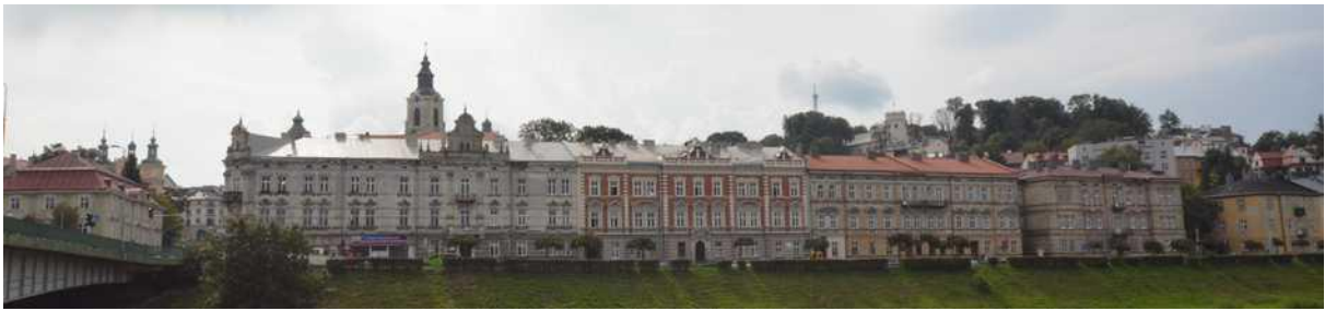
Fot 1. Widok panoramiczny kluczowy. Ekspozycja bierna – widok z Deptaka nad Sanem na Stare Miasto od strony wschodniej. Fot. Łukasz Stachurski
