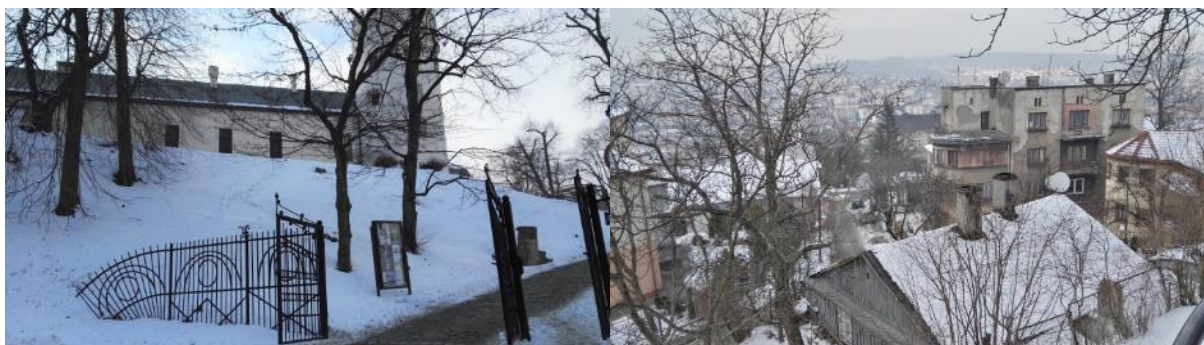
Fot. 15 i 16 Zamek (z lewej) i zniszczone budynki mieszkalne w jego otoczeniu (z prawej).
