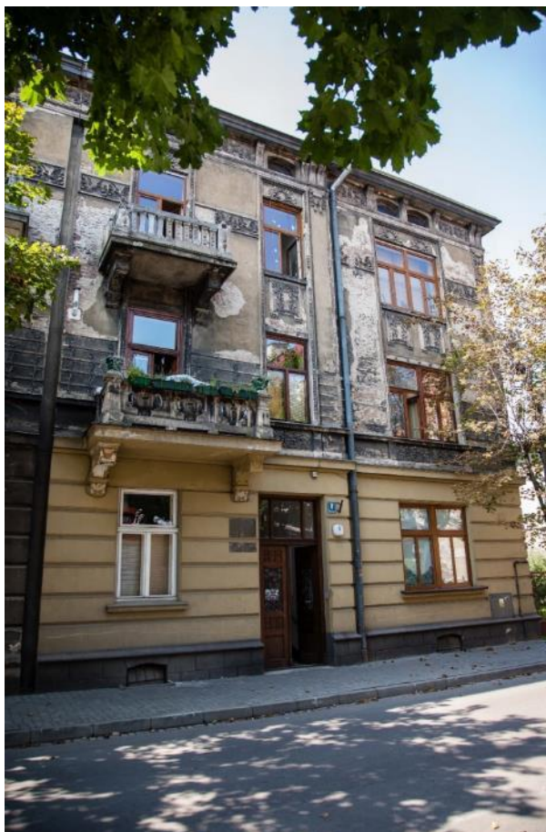
Fot. 20 Kamienica przy ul. A. Puszkina.
