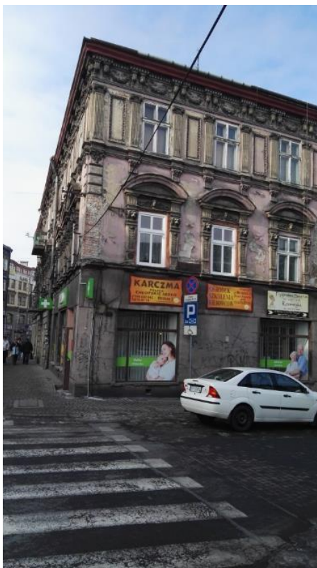
Fot. 4 Ulica Mnisza – zabytkowa kamienica w złym stanie technicznym oraz nawierzchnia ulicy.
