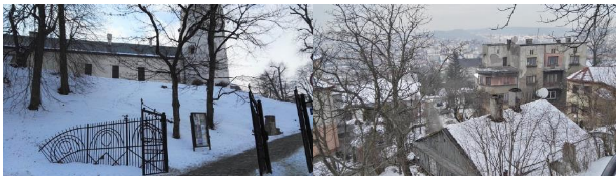
Fot. 15 i 16 Zamek (z lewej) i zniszczone budynki mieszkalne w jego otoczeniu (z prawej).
