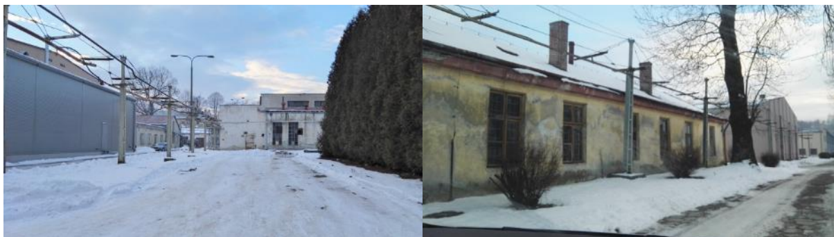
Fot. 24 i 25 Zabudowania produkcyjne w rejonie ulicy Herburtów.
