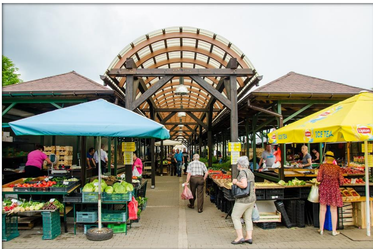
Rys. 2 Przebudowa placu handlowego "Zielony Rynek" w Przemyślu
