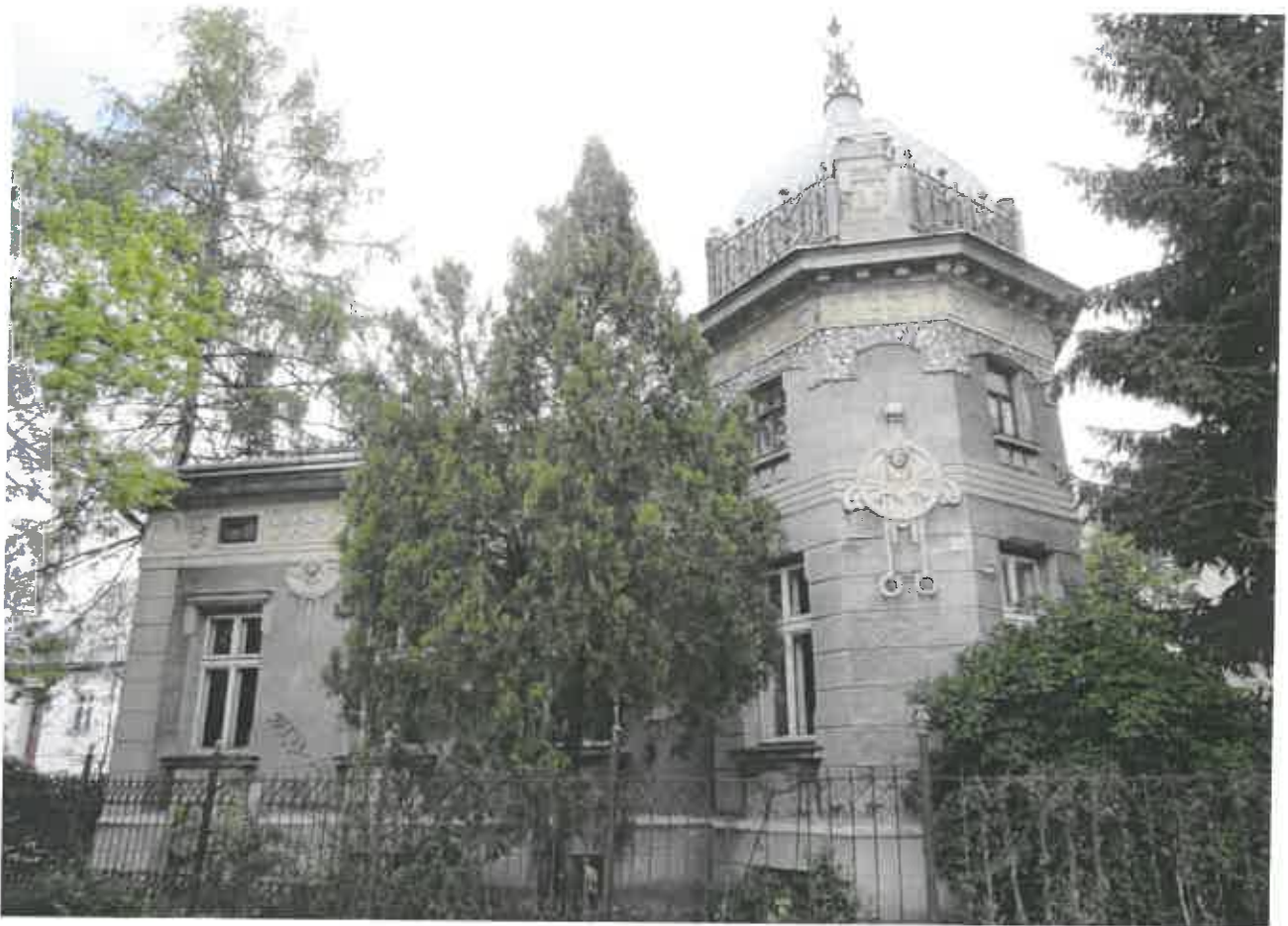
Ryc. 43. Willa przy ul. Puszkina 15 wraz z ogrodzeniem wpisana do rejestru zabytków pod numerem A-1804 dnia 21 września 2023 r.
