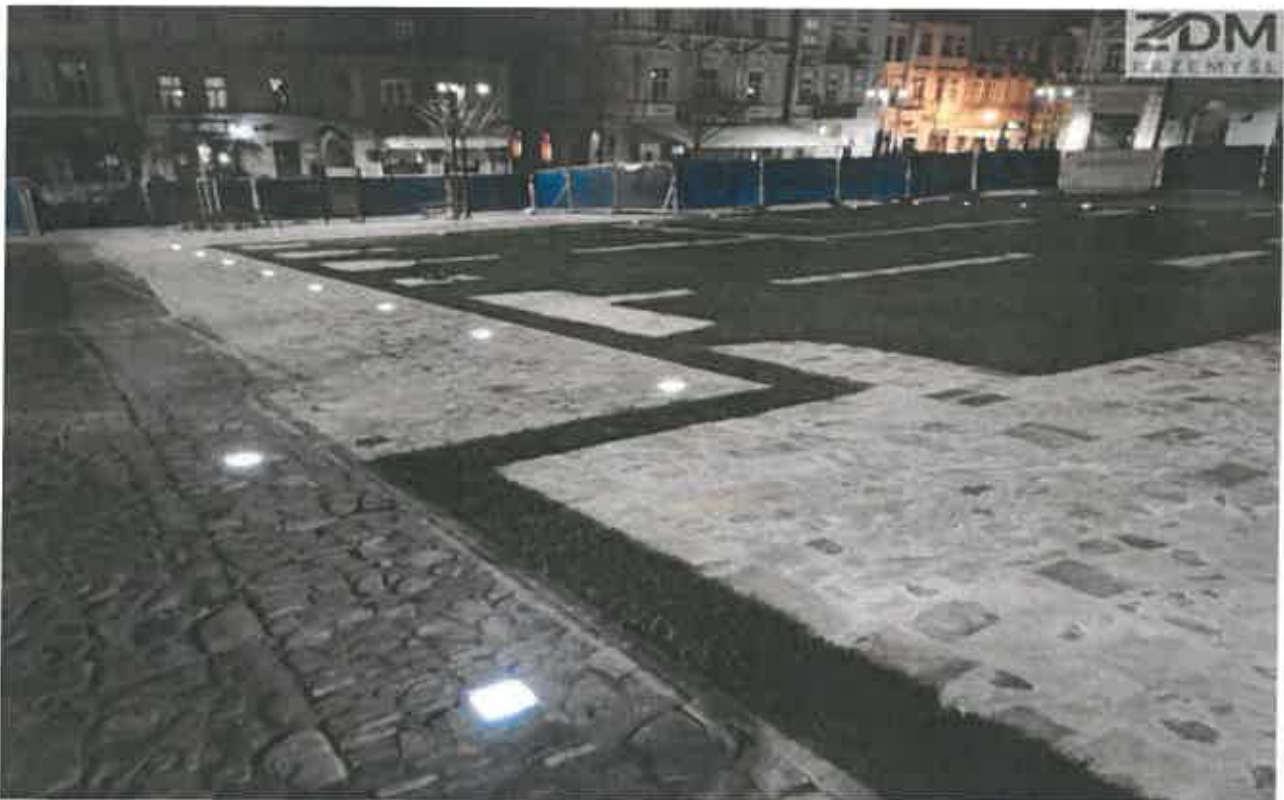
Ryc. 10. Fragment płyty rynku w Przemyślu po przebudowie
