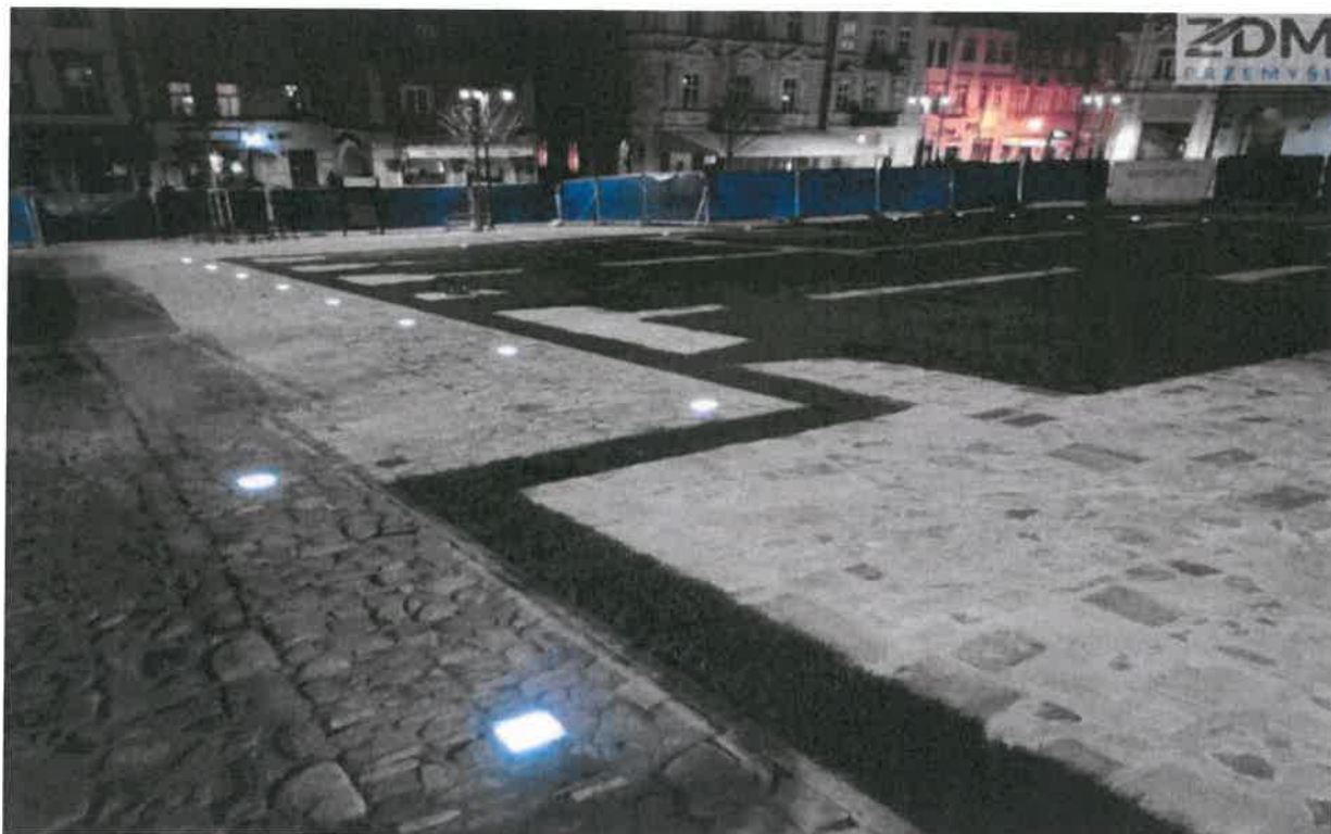
Ryc. 10. Fragment płyty rynku w Przemysłu po przebudowie
