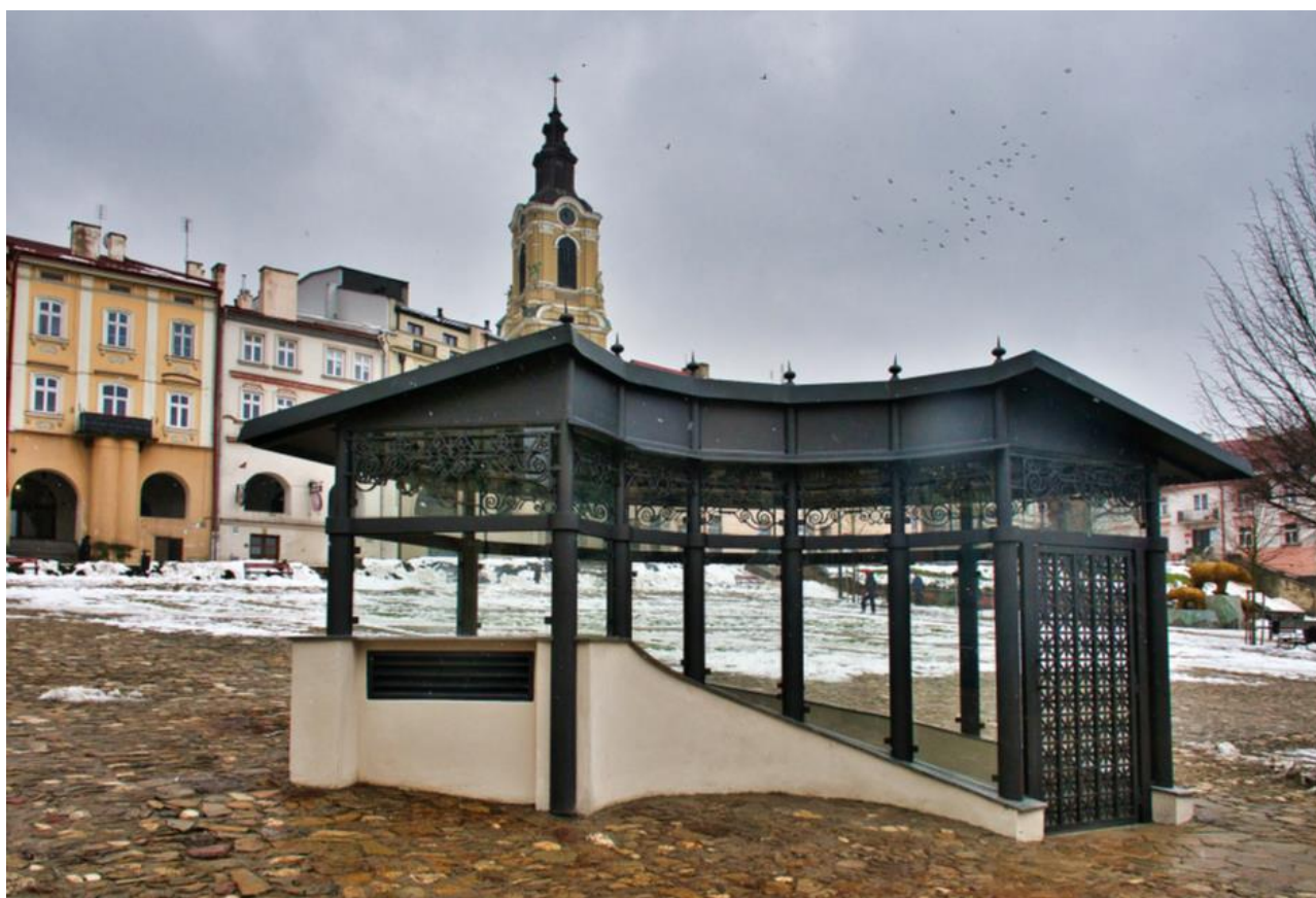
Ryc. 9. Wyjście ewakuacyjne z Podziemnej Trasy Turystycznej Źródło: Urząd Miejski w Przemyślu
