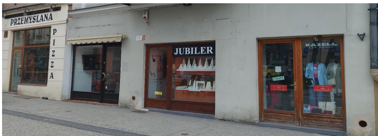
Ryc. 36. Widok na zmienione witryny sklepów w parku kulturowym Źródło: Urząd Miejski w Przemyślu
