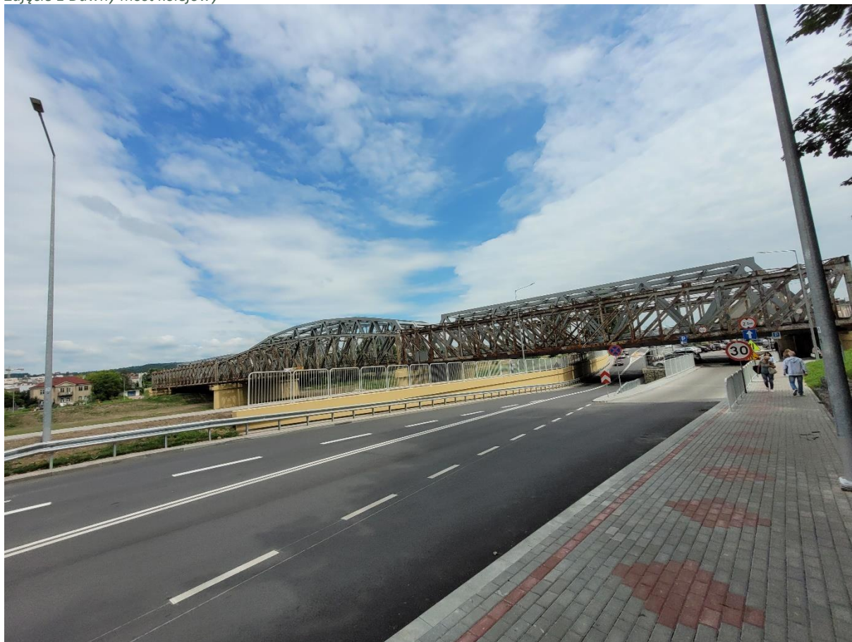
Zdjęcie 1 Dawny most kolejowy
